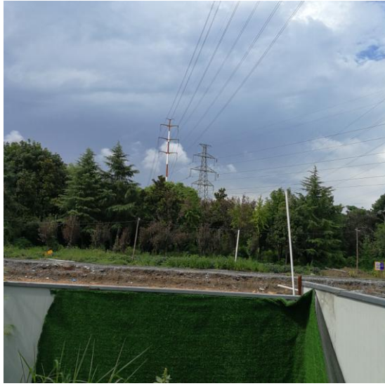
线路跨越嘉杭路照片 1（现状）
