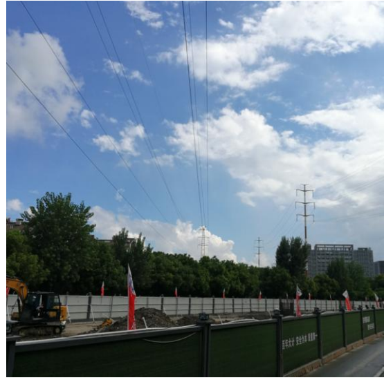
线路跨越嘉杭路照片 2（现状）
