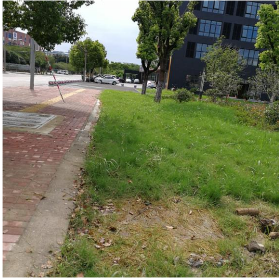
华严路绿化带照片（电缆）
