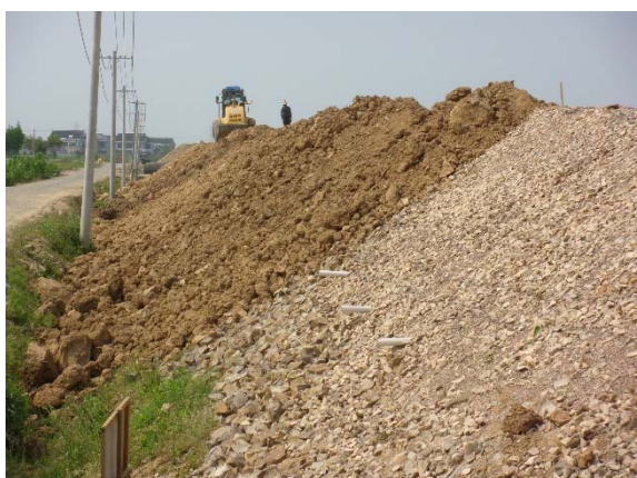
路基边坡覆土
